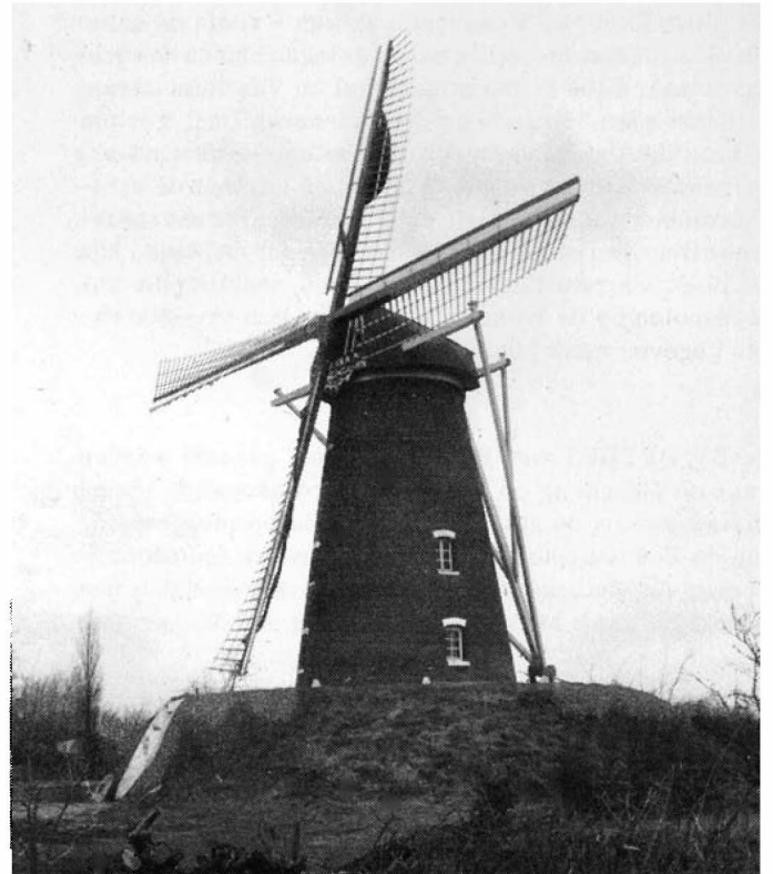
Na de restauratie.; 18 maart 1968 Foto: P.W.L.
